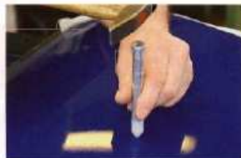
Mit einem Kunststoffdorn ebnet Schröder nun die kleine Beule ein
